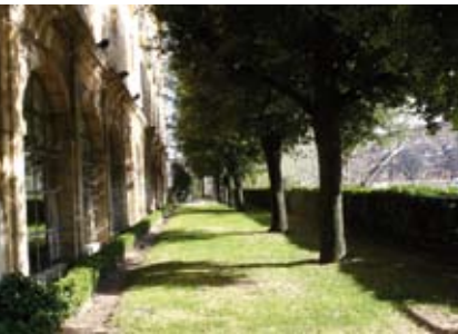
Fachada hacia el río Bernesga
