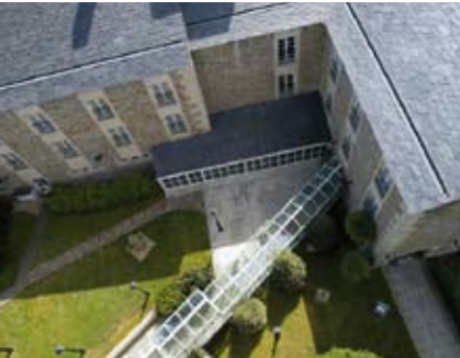
Vista desde lo alto de la Torre del edificio de nueva planta y la galería que lo comunica con el baluarte.
